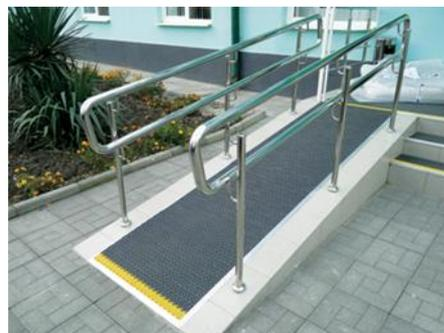
Стационарные пандусы подразделяются на однопролётные либо двухпролётные, имеющие переходную горизонтальную площадку.
