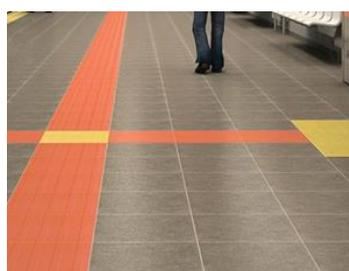
Специальные объемные тактильные плитки и другие варианты напольных тактильных покрытий (например, встраиваемые направляющие полосы и биты) формируют рисунок, позволяющий незрячим людям получать информацию о безопасном пути движения (направления движения, повороты) и о наличии препятствий на пути движения (пороги, перекрестки, ступени, лестницы, столбы или колонны, двери, пешеходные или подземные переходы).
